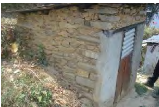
Toilet at Ch 18+980
